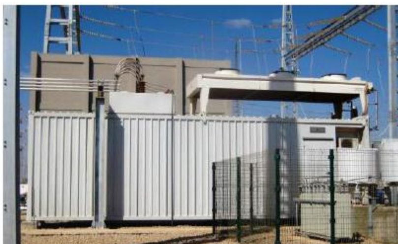
3.6 – сурет - Басқарылатын шунттаушы реактордын реттегіші
